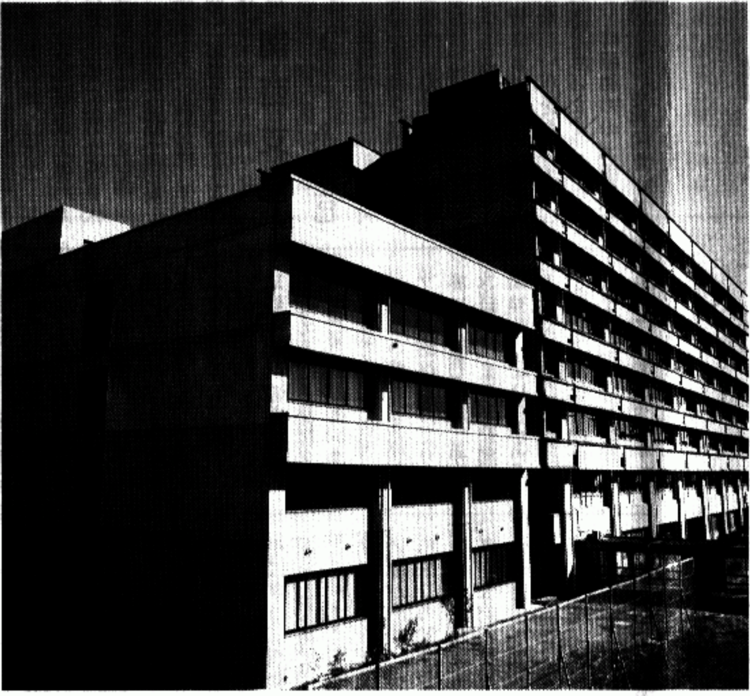
最近の電気・情報館 (手前が新研究棟)
